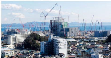
建設中の横須賀石炭火力発電所
